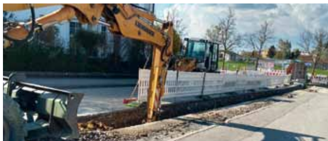
Bauarbeiten für die Verlegung der Rohre im Wärmeleitungsnetz, die leider temporär zu Verkehrsbehinderungen führen.
