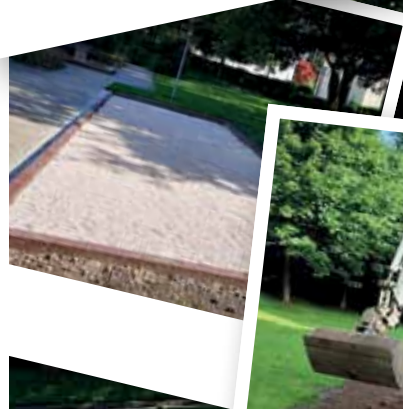
Fleißige Helfer beim Entstehen der neuen Boule-Bahn für Markt Schwaben
