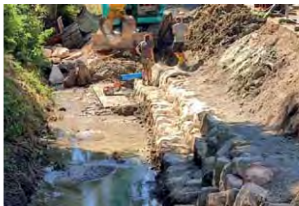
Nur mit schwerem Gerät sind diese Erdmassen und Steine zu bewegen. Der Baggerführer beweist viel Feingefühl beim präzisen Einbau der Steine.
