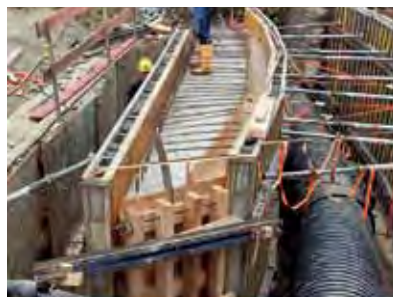
Die beiden bogenförmig verlaufenden Seitenwangen der neuen Hennigbachbrücke im Angerl bilden an dieser Stelle zugleich das Bachbett.
