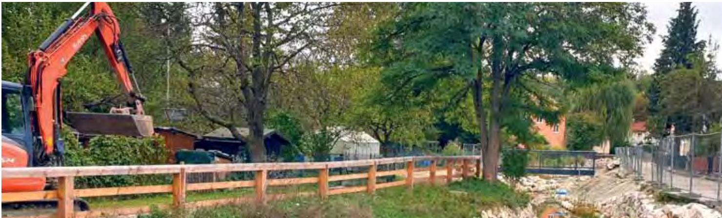
unten: Die Renaturierungsarbeiten entlang des Hennigbachs sind bereits sichtbar. Im Hintergrund der neue Steg zur Kleingartenanlage.
